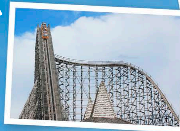
Jede Menge Holz: »Colossos« heißt diese 1.344 Meter lange, knapp 60 Meter hohe Achterbahn im Heide Park Soltau
